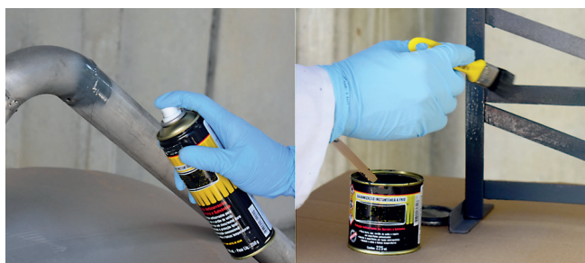
Exemplos de aplicação de tinta rica em zinco
