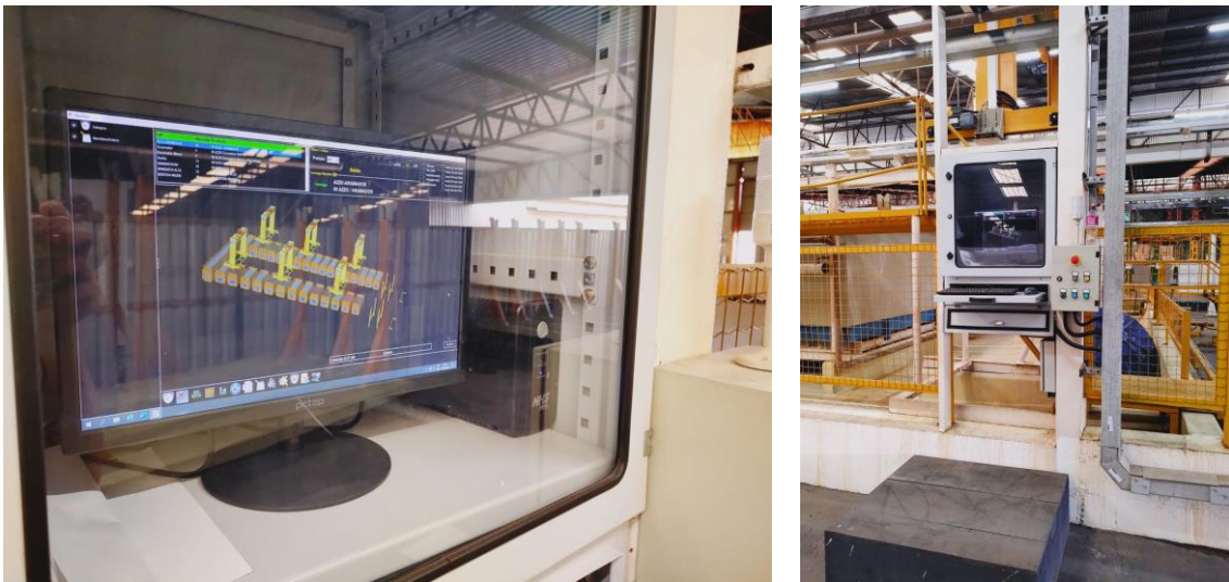
Figura 15 - Central de comando operacional
