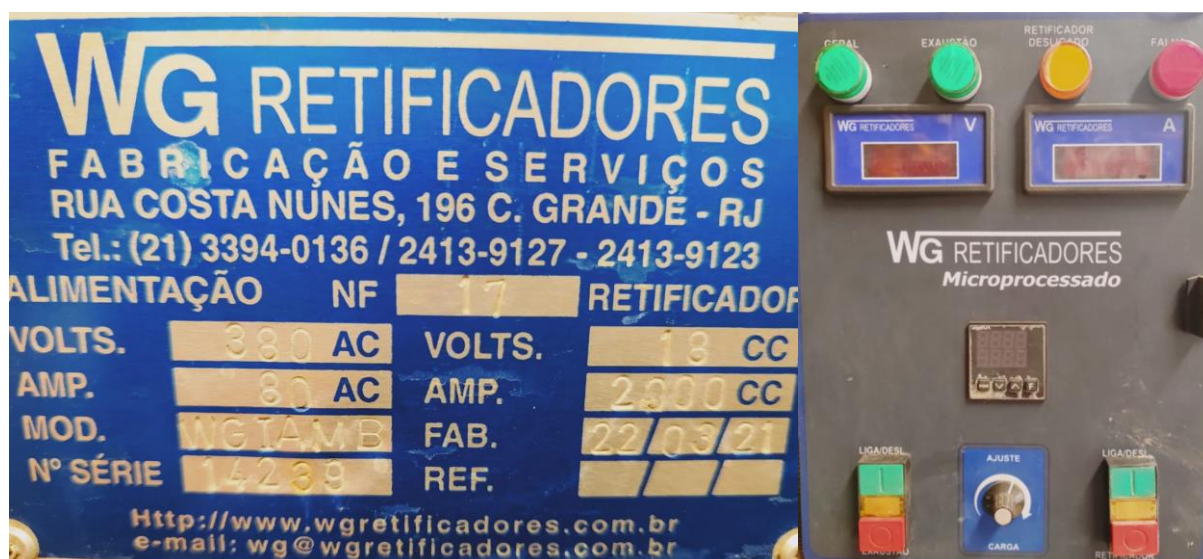
Figura 6 - Descrição de retificador 18 volts
