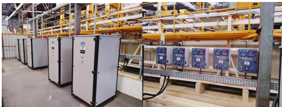
Figura 4 - Retificadores linha de pré-tratamento
