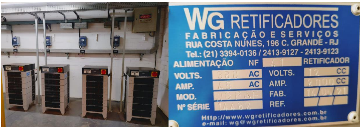
Figura 7 - Retificadores de níquel
