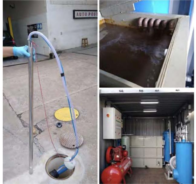
**Figura 6:** Sistema de remediação para uma área contaminada.
